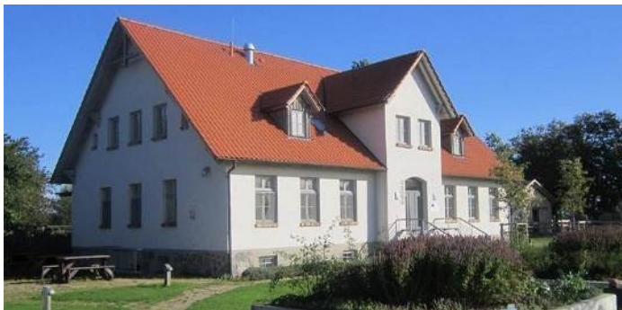
Stahlbrode, Amt Miltzow, Bömitz ( www.guthaeuser.de )
